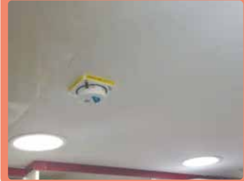
전통시장 화재감지 IoT 시스템
